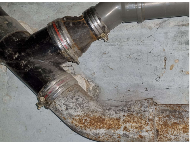
Eksisterende faldstamme i støbejern med ny plast forgrening.
