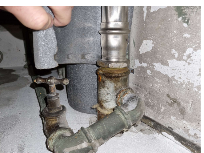
Nye rustfrie rør monteret sammen med eksisterende galvaniserede rør.
