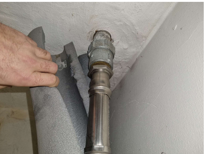
Nye rustfrie rør monteret sammen med de gamle galvaniserede rørsystemer.
