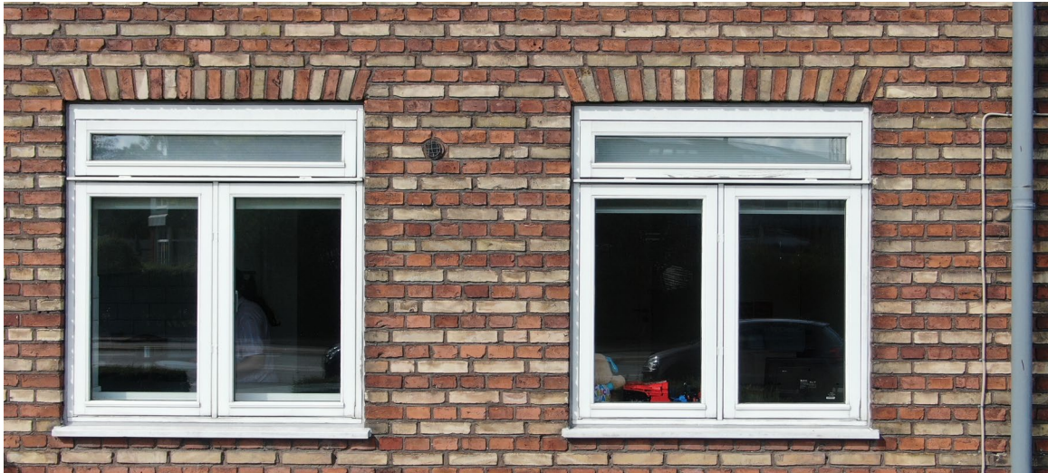
Visualisering af facade med lydluftventiler i vinduerne.
