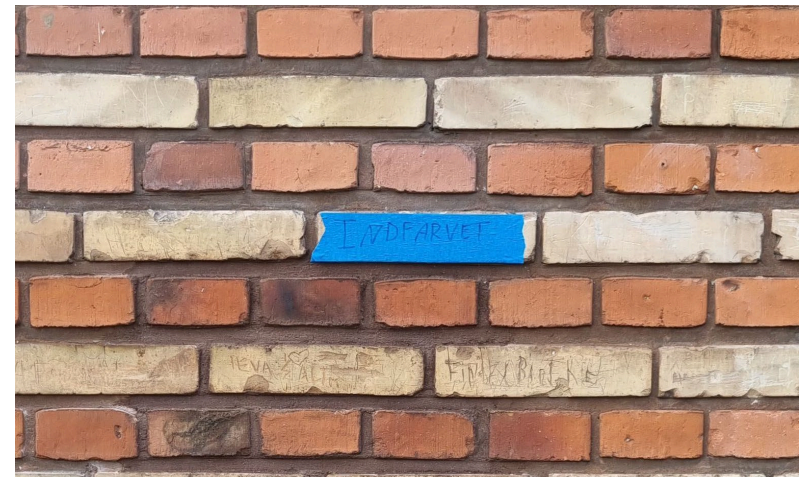
Fugeprøve udført på gavlen ved Heldbovej 111
