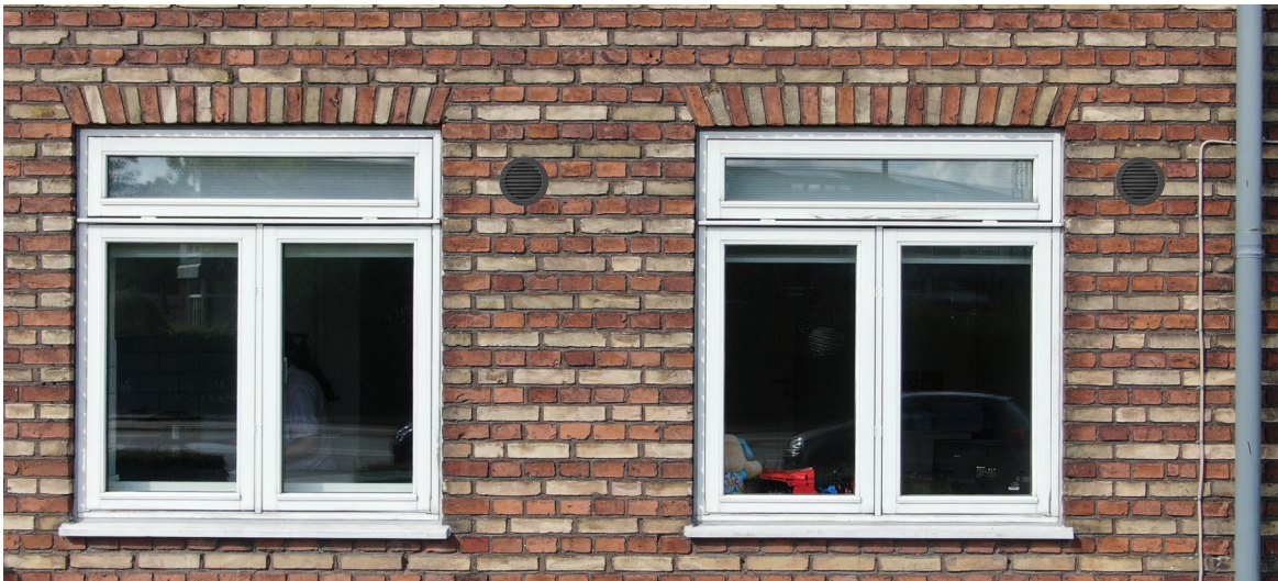
Visualisering af facade med murventiler.
